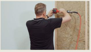
3 START ASSEMBLY FROM LEFT TO RIGHT. ADD HORIZONTAL BATTENS IN CORNERS AND AT DOORS/WINDOWS.
